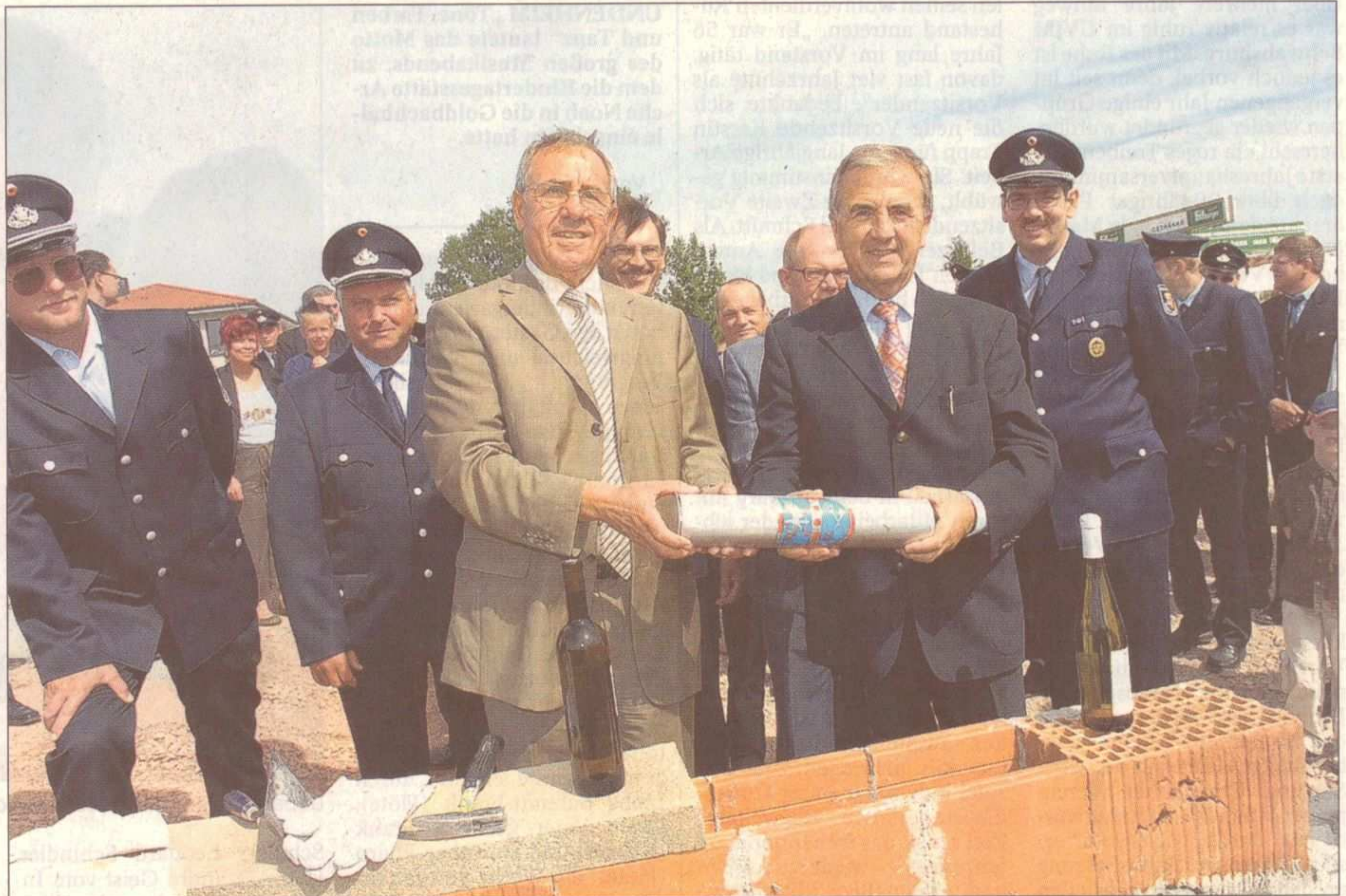
Gemeinsam mit Verbandsbürgermeister Robert Kunnen (l.) legte Landrat Klaus Schick (r.) den Grundstein für das Feuerwehrhaus
